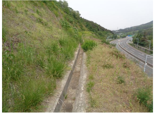
1소단 배수로 전경
