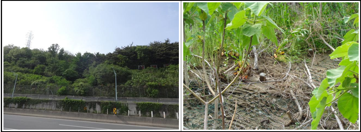
【그림 1.3.8】보호/보강시설 전경
