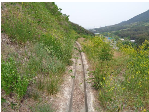
2소단 배수로 전경
