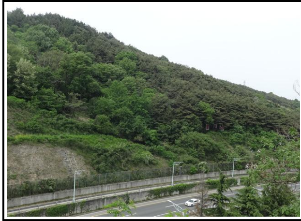
【그림 1.3.5】상부자연사면 전경
